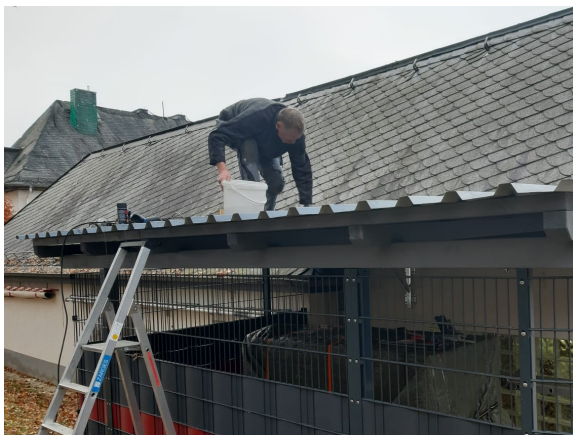
Montage der Trapezbleche / Überdachung
