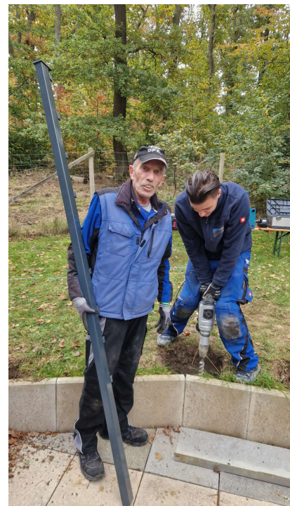
Axel Wahrhusen und Kevin Schwarze bei der Montage der Zaunanlage
